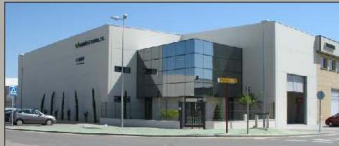
Almacén de Productos Fitosanitarios - Calahorra
