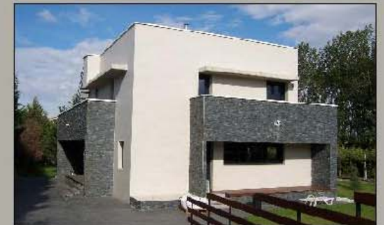
Vivienda Unifamiliar - San Adrián
