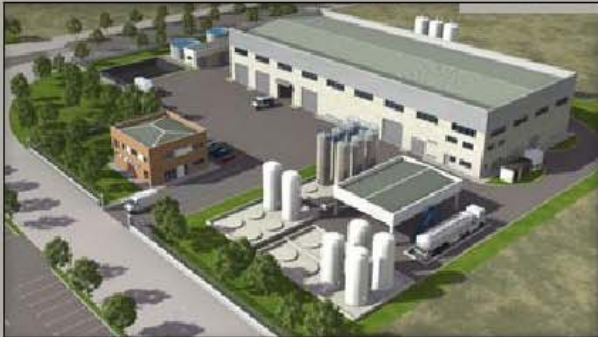
Planta de Tratamiento Físico-Químico - Zaragoza
